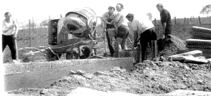
ERSTE ARBEITEN AM SPORTHEIM AUF DEM SPORTPLATZ IN OBERHATTERT IM JAHR 1971
